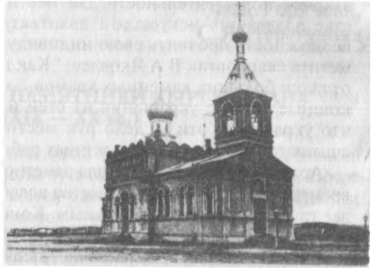
Рис. 10. Арысь. Церковь Святителя Алексия. Северо-западный фасад. 1913 г.
